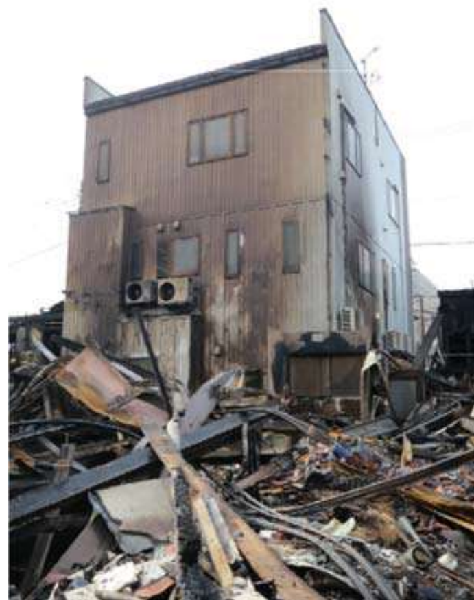
火元建物から5軒風下の準耐火建築物
