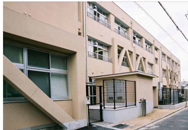
浜小学校耐震改修
