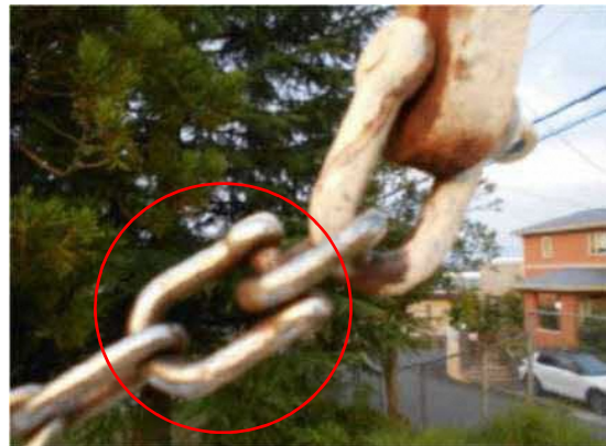
同形状のシャックルの使用状況
