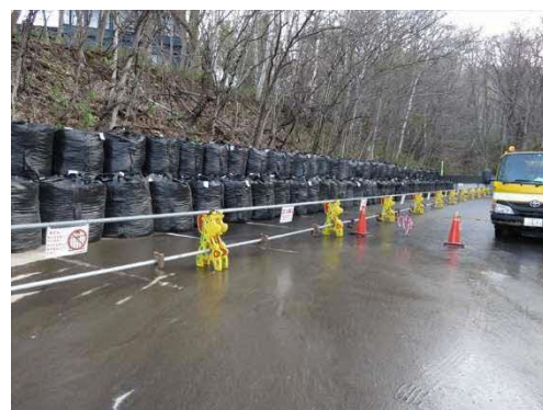
応急復旧完了
