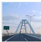
1. 岸和田大橋(阪神高速湾岸線)
