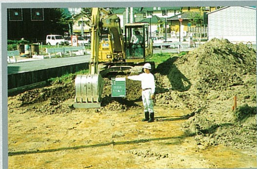
▼スキ取り工事
