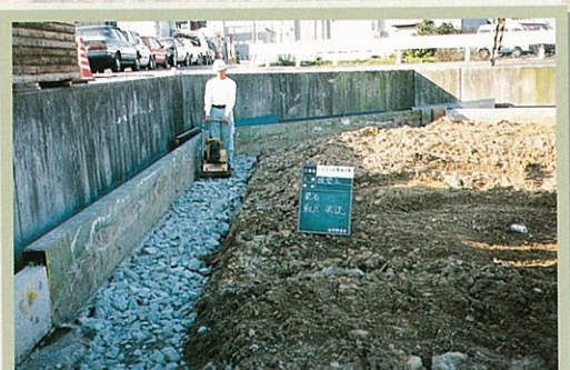
▼栗石 転圧工事
