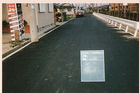
街路築造工事
