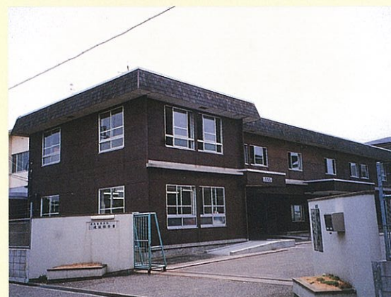
●岸和田市建設部分室
