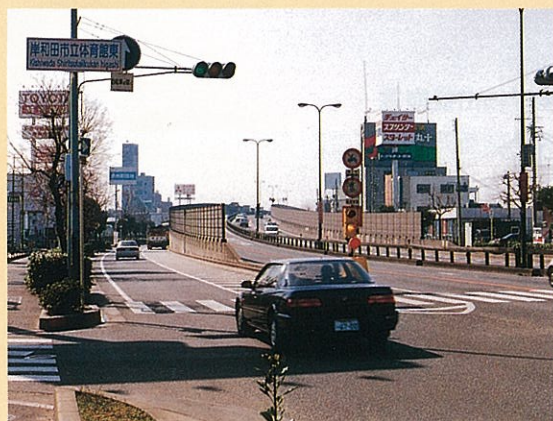
▲国道26号(立体交差部)
