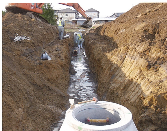
汚水管布設工事
