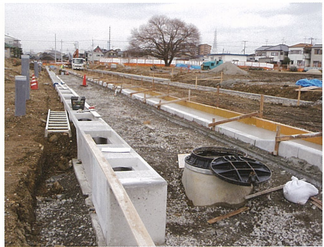
道路築造工事
