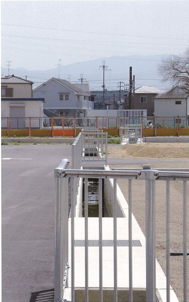
転落防止柵付水路
