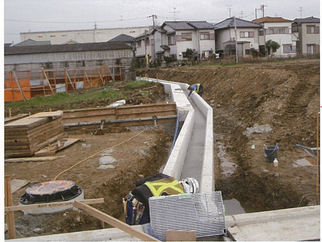
水路築造工事
