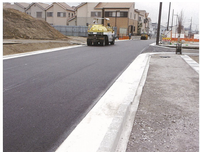
舗装工事(表層)
