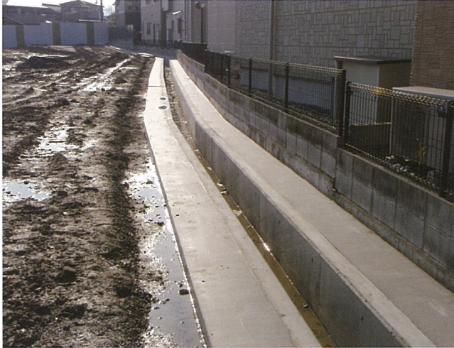
水路築造工事
