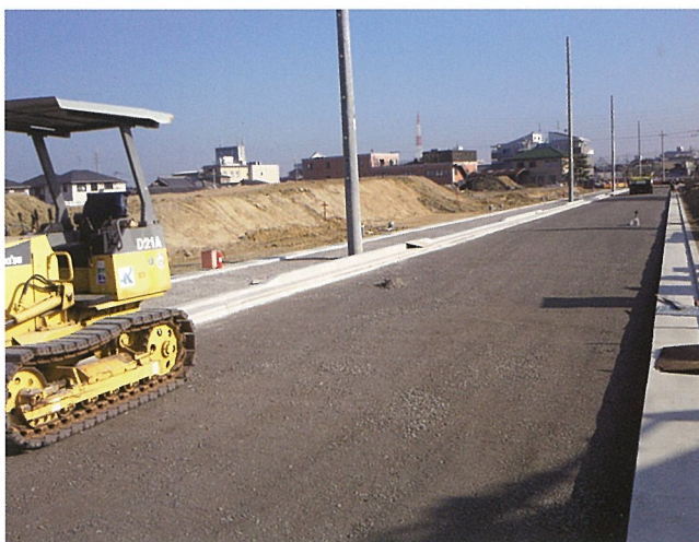
舗装工事(路床)
