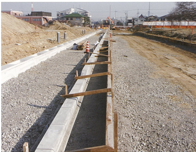
道路築造工事(歩道)
