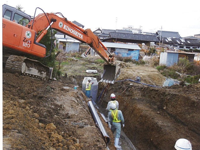
汚水管布設工事
