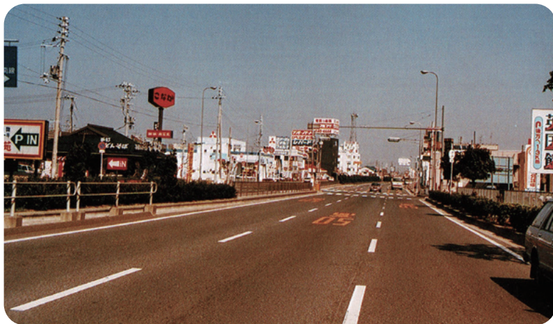
完成した第二阪和国道（八木地区）[1985 年]
