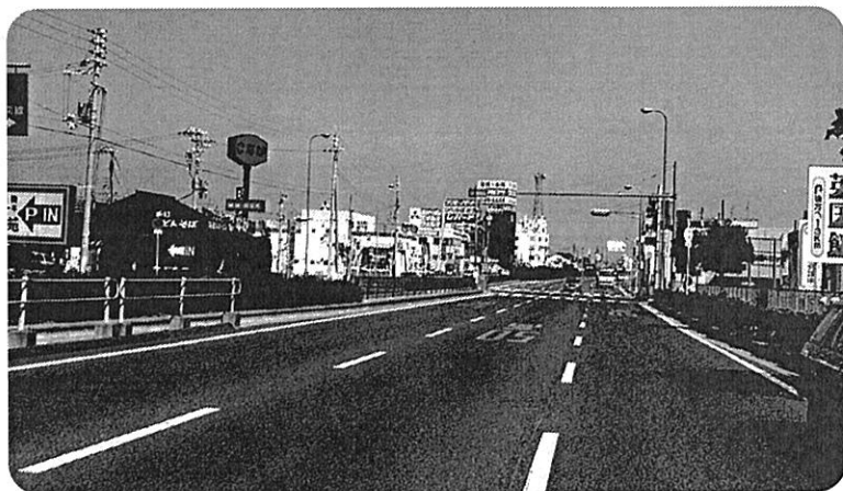
完成した第二阪和国道（八木地区）[1985 年]
