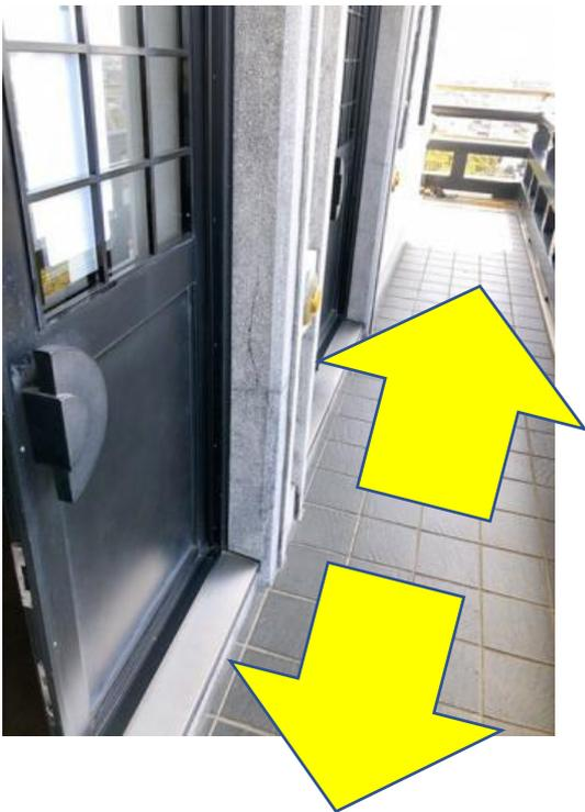
望楼へ出る箇所は、望楼側の床の高さを上げて3階と望楼の高さをフラットにし、そこからスロープにすることを検討。
