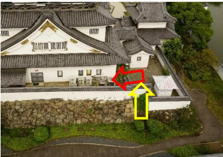
段差解消機から城内への動線について、1階展示室の裏口（岸高側）からの動線を検討。段差解消機を大天守側の石垣の高さ（約4m）まで設置し、渡り廊下のような形で大天守へ繋ぐ形を検討。
