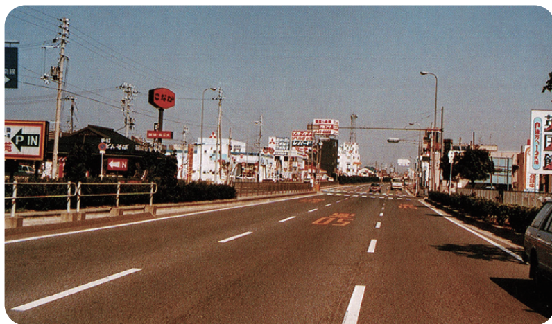
完成した第二阪和国道（八木地区）[1985 年]
