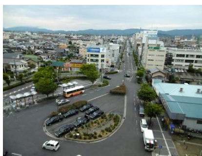
岸和田駅前交通広場
