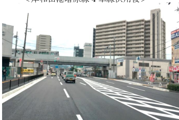
＜岸和田港塔原線 4 車線供用後＞
