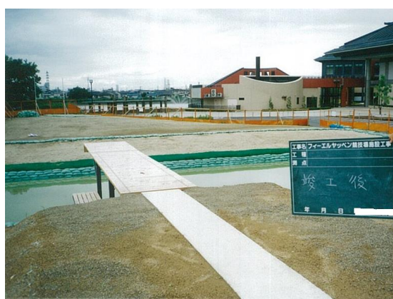
(参考) フェーエルヤッペン竣工写真
