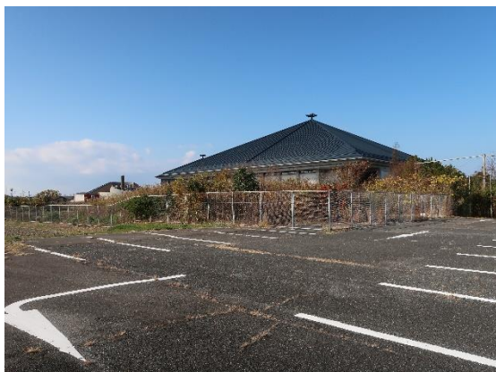
【写真①】対象地を南東方向から撮影
