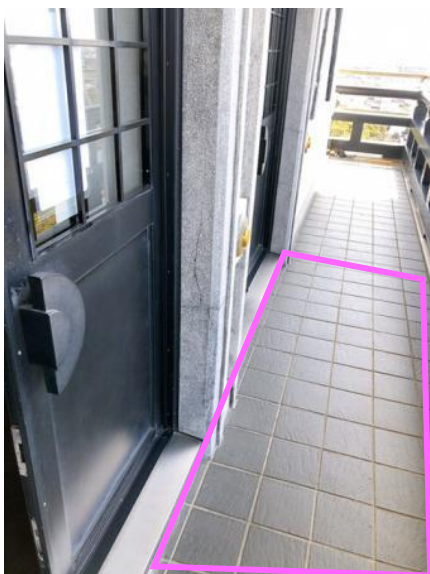
写真 7 回廊のスロープ設置箇所
