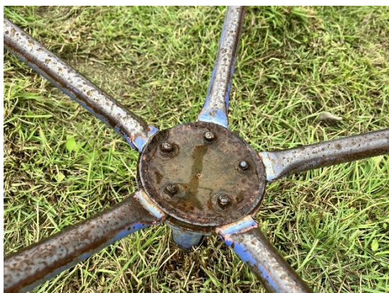
事故の原因となったボルト
