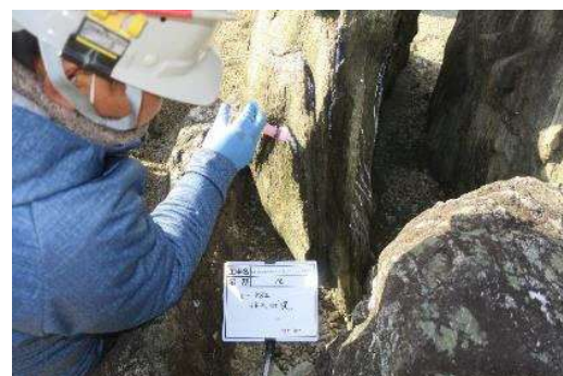
亀裂 割れ等の補修工程
