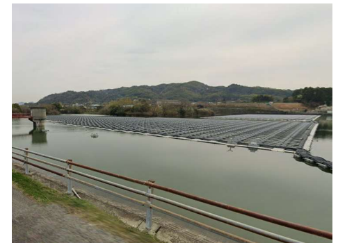
ため池に設置
