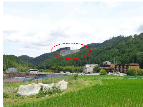
山の斜面を切り開いて設置
