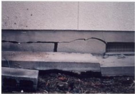
基礎が大きく破損している
