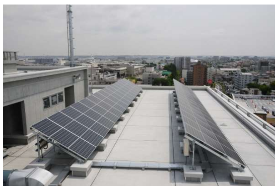
屋上に太陽光パネルの設置（平塚市）
