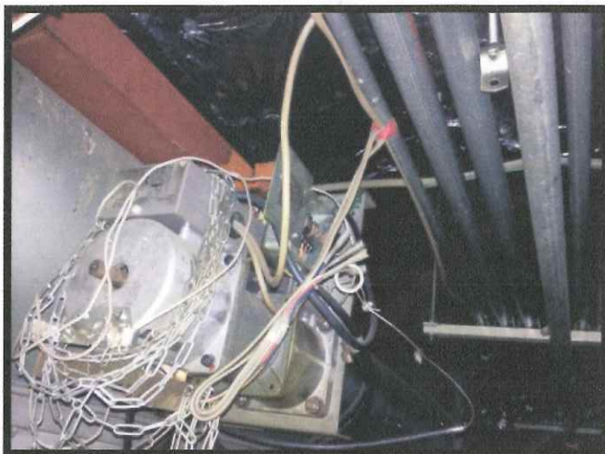
シャッターモーター 巻き上げ用チェーン
