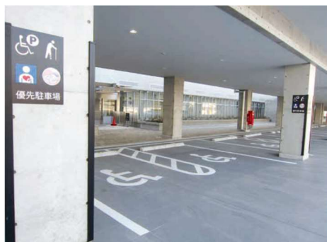
ユニバーサルデザインに配慮した駐車場（平塚市）
