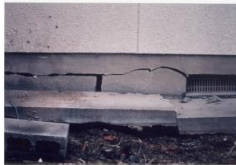
基礎が大きく破損している
