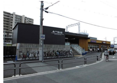
春木駅西側新駅舎
