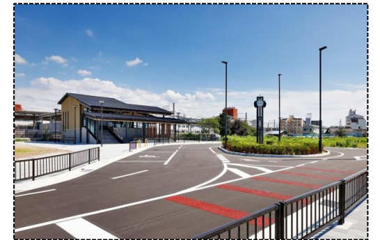
久米田駅西側新駅舎
