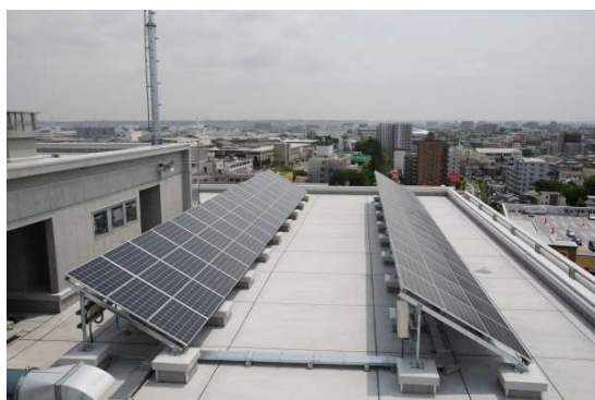
屋上に太陽光パネルの設置（平塚市）
