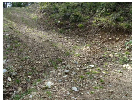
素掘りによる横断溝
