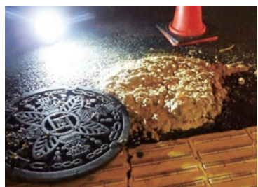
マンホール蓋からあふれ出る固まった油
