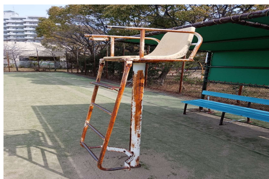
審判台の劣化(野田公園テニスコート)
