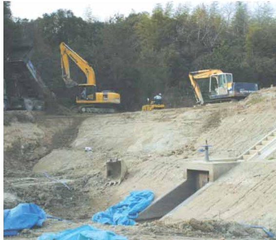
改修が進む底間池（岡山町）
