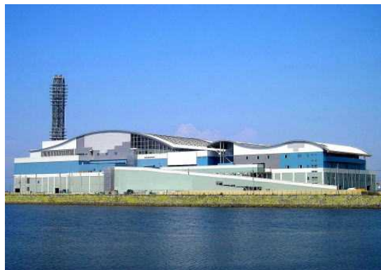
岸和田市貝塚市クリーンセンター
