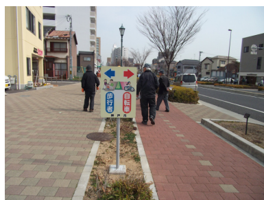
須磨区〈市道 中央幹線〉 (写真左) 舗装材の色により自転車・歩行者の通行位置を区分 (写真右) 植樹帯による構造分離
