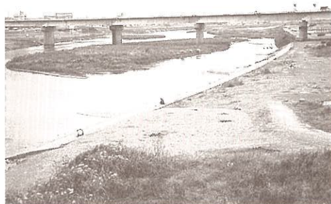
写真１３ 自然らしさを演出する護岸形状 （大きく柔らかい汀線、水制工の曲線）
