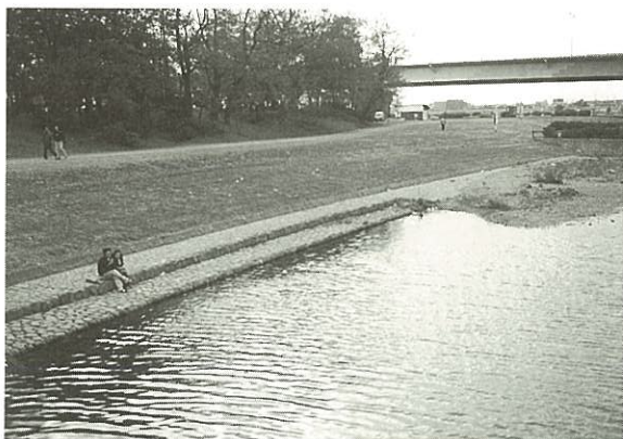
写真１７ 階段護岸と緩傾斜の護岸 （東京都、野川）
