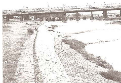
写真１４ 水草の生えた水制工
