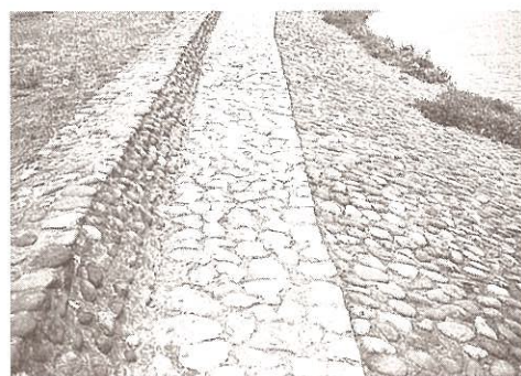
写真１６ ２段化された肩部と素材の違いによる空間的分節
