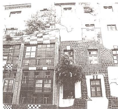
壁面の緑化(ウィーン)
