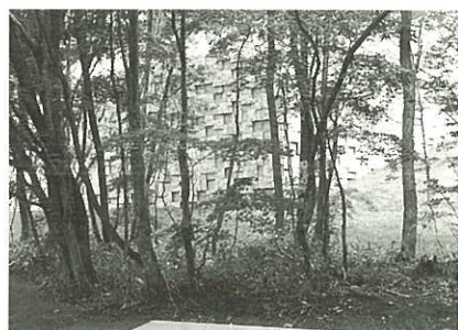
大きい擁壁を疑岩擁壁に、壁前に樹木 (札幌)
