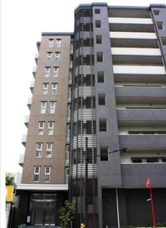
屋外階段の形態を工夫し、建築物の意匠と一体化することで、目立たせない配慮を図っている
