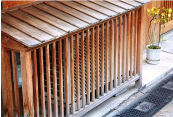
クーラーの室外機に木製ルーバーを設置することで、歴史的まちなみに調和させている。
