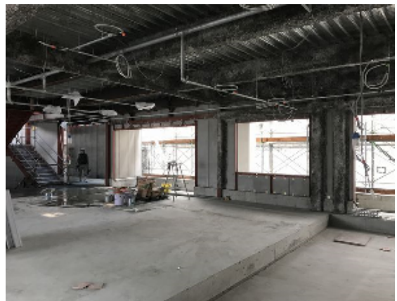
3階和室、交流室、間仕切り前です。
