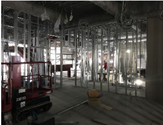
1階資料室付近、室の間仕切りが入ってきました。
