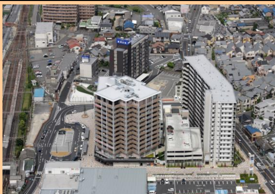
土生町・東岸和田駅東（高架工事中）
