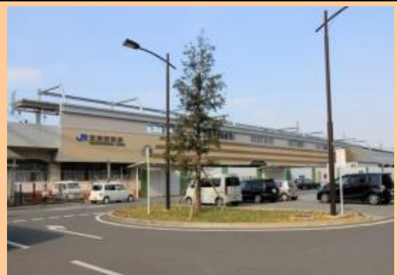
東岸和田駅舎（高架工事中）
