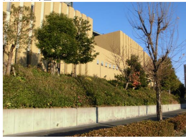
法面やよう壁
