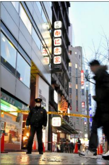
写真① 突出看板落下の事故例 (2015.02札幌市で発生) 出典:朝日新聞
