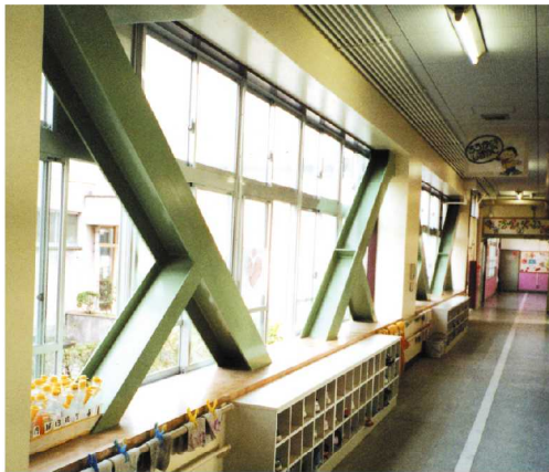
耐震補強が施された校舎（山直南小）
