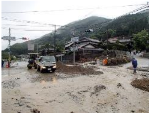
大雨による土砂災害
