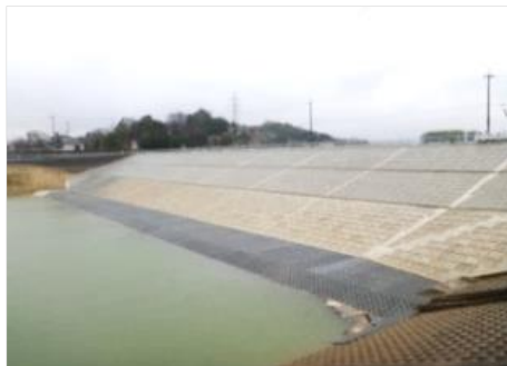
老朽ため池の改修
