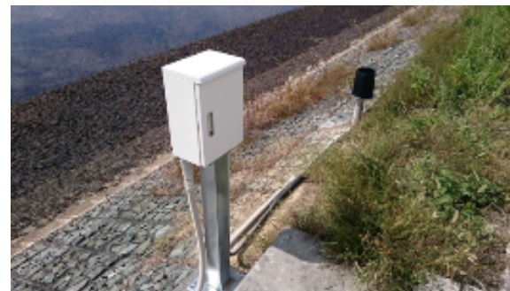
観測機器の設置
