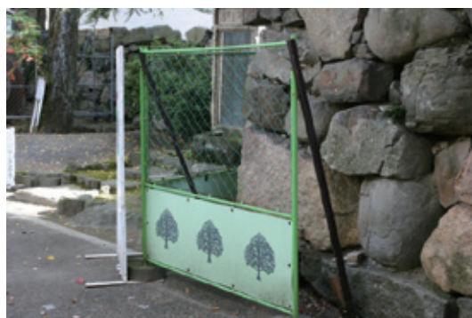
竹がない状態の工事用フェンス
