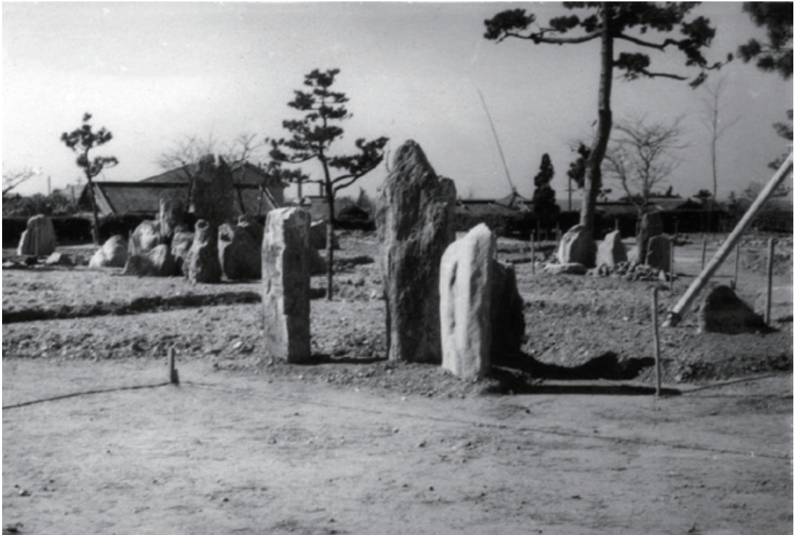
施工直後の天陣（昭和 28 年）
