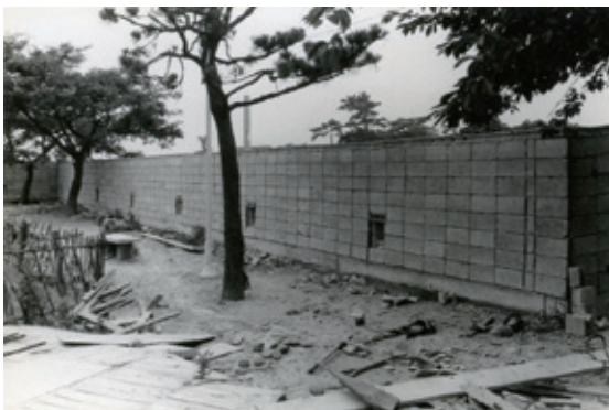
南側土塀施工状況（昭和 45 年～ 46 年）
