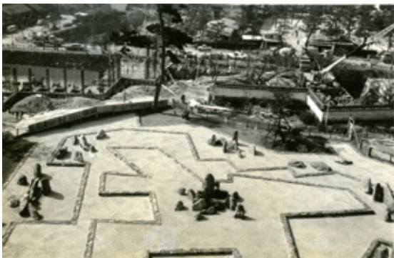
隅櫓、多聞櫓建設状況（昭和 44 ～ 45 年）
