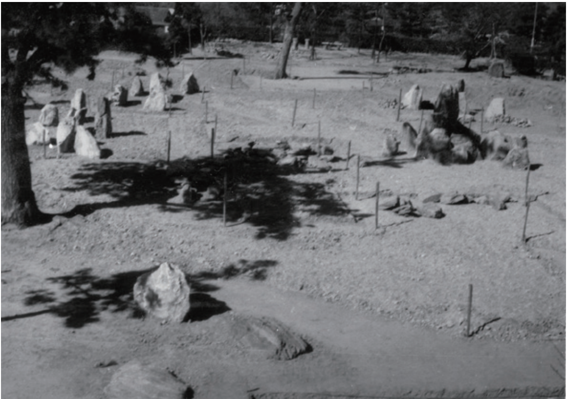
施工中の石組（手前は雲陣 天守閣が建つ前の天守台上から撮影）（昭和 28 年）
