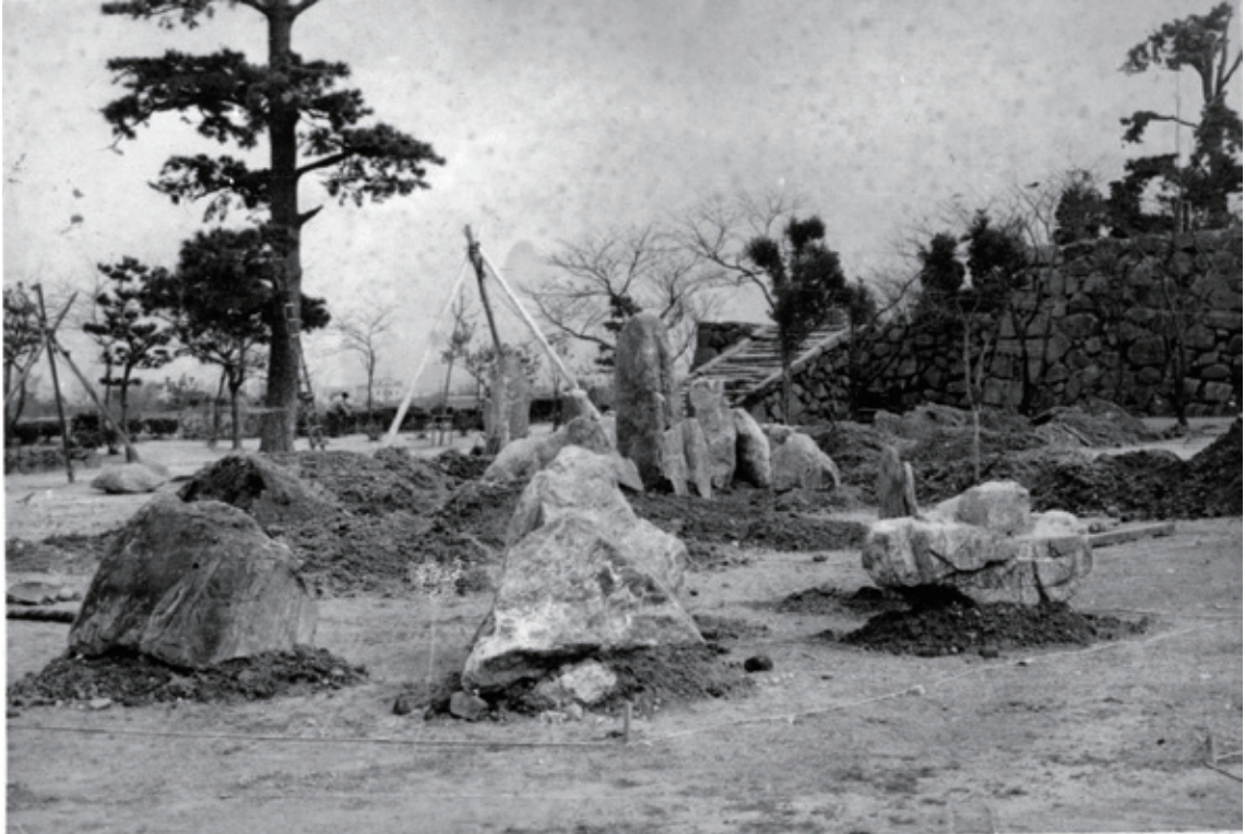
石組設置中（根石を噛ませた風陣と施工中の大将）（昭和 28 年）
