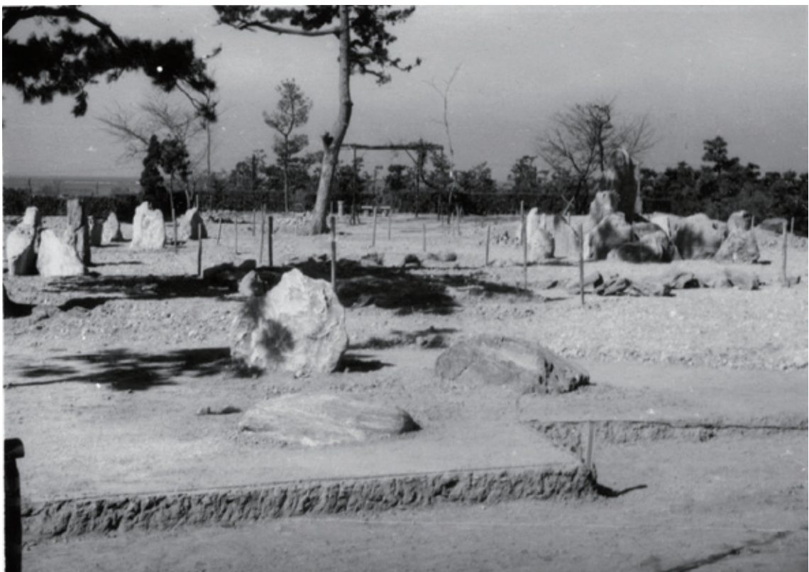
施工直後の雲陣（昭和 28 年）
