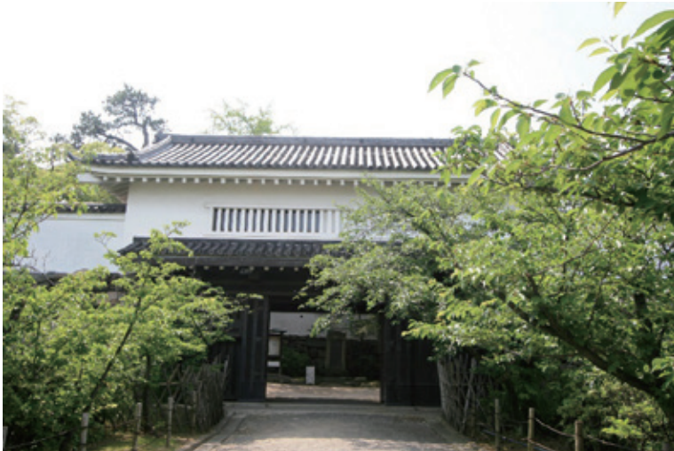
現在 黒地木板黒鉄板押鍼止仕上げ（平成 29 年）
