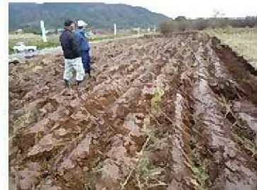
右：シノ竹が密生した箇所は、整地作業を来春に持ち越す
