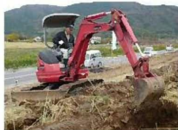
左：ブラウで反転しない部分は、建機で作業
