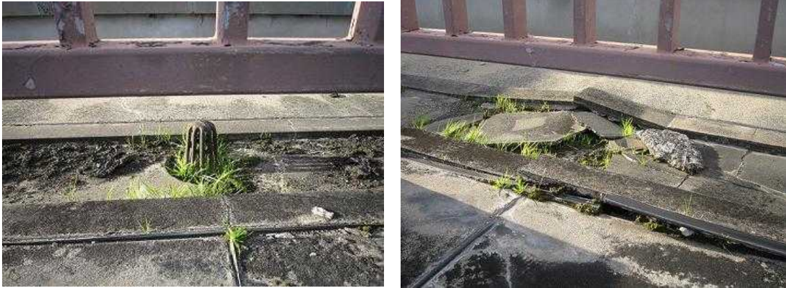
図1 本市庁舎屋上の様子
