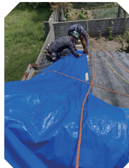
ブルーシートを張り替える様子
