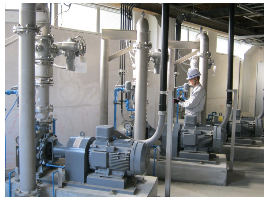
写真：送水ポンプの点検作業
