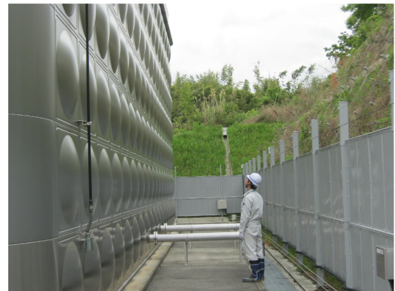
写真：神於山北配水池の点検作業
