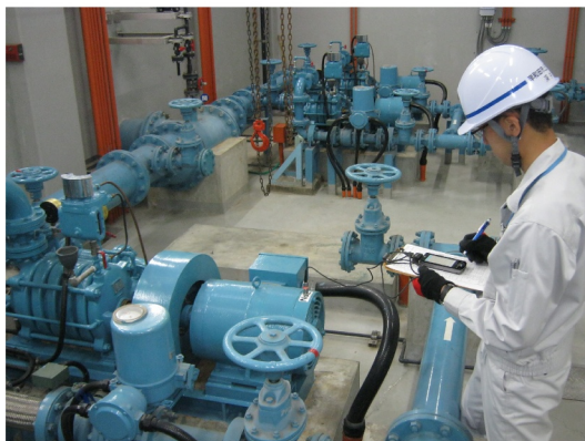
写真：配水ポンプの振動測定作業
