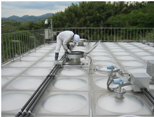
写真：水位計の確認作業
