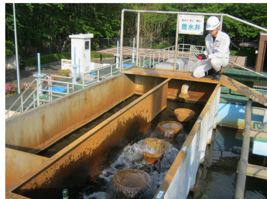
写真：着水井*の点検作業
