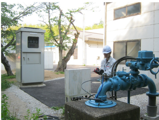
写真：1号さく井の点検作業
