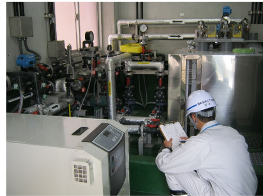
写真：薬品注入機の点検作業
