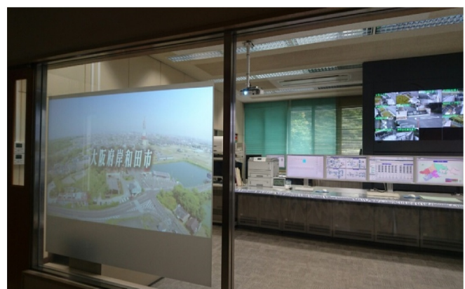
写真：流木浄水場管理棟内
