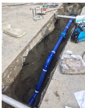
写真：老朽化管路の更新
