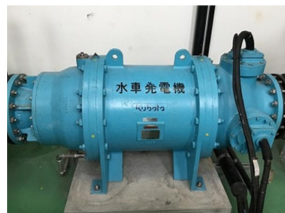
写真：小水力発電機
