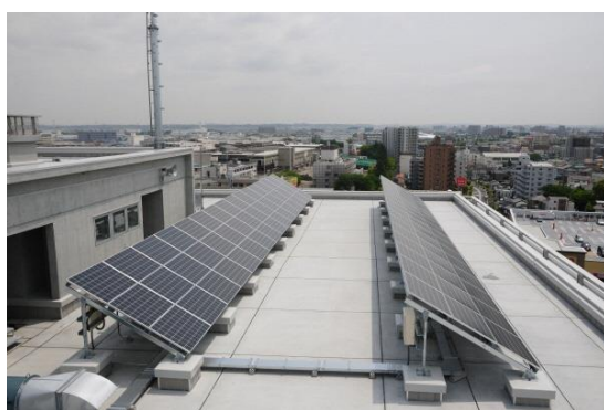
屋上に太陽光パネルの設置（平塚市）
