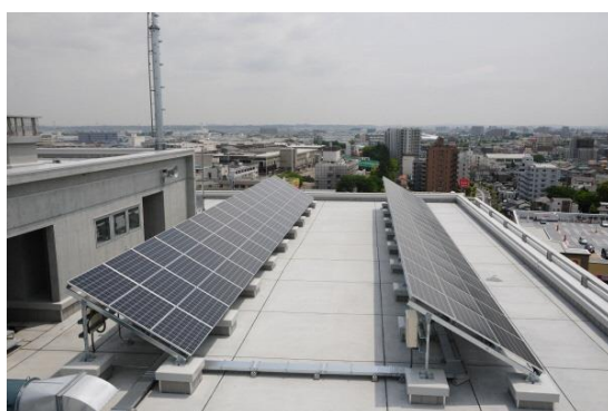
屋上に太陽光パネルの設置（平塚市）
